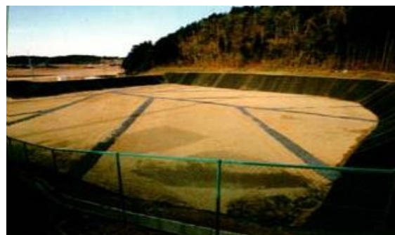
[成東一般廃棄物最終処分場]
